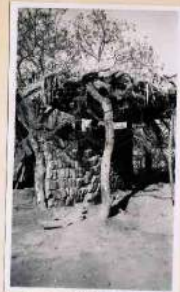
Ramada criollo de troncos de algarrobo, ladrillos cocidos y techos de caña cañaveral y palma. Alrededores de Villa del Rosario, Dep. Río Segundo (Córdoba). Del rancho de D. Jesús Arguello. Octubre de 1947.
