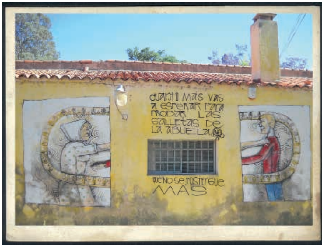
29| Una de las paredes donde funcionó el centro clandestino de detención Campo de La Ribera. Foto: Vanesa Garbero, 2012.
